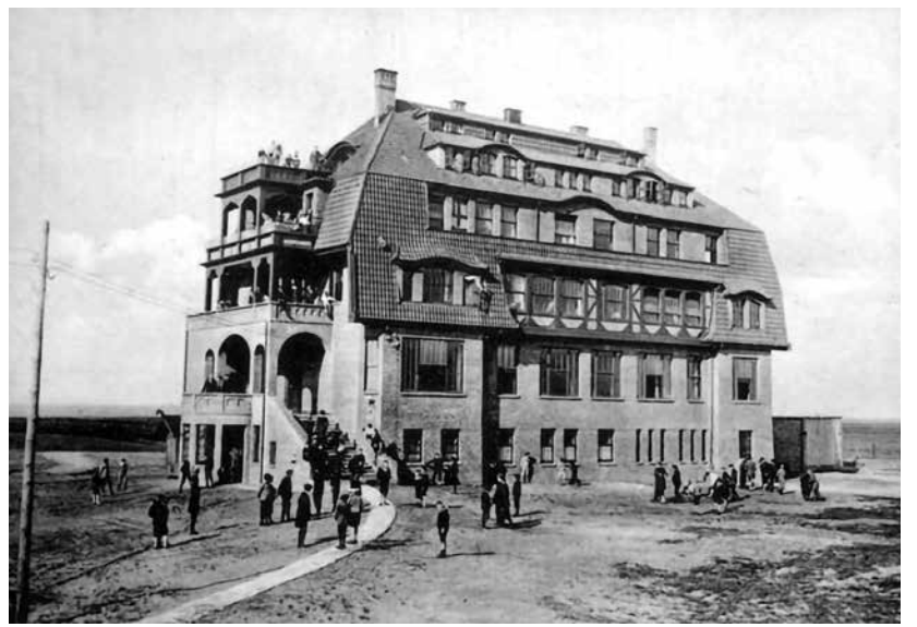
Das Nordsee-Pädagogium am Wyker Südstrand Im Moment wird das Gebäude saniert und umgebaut zu Wohnungen
